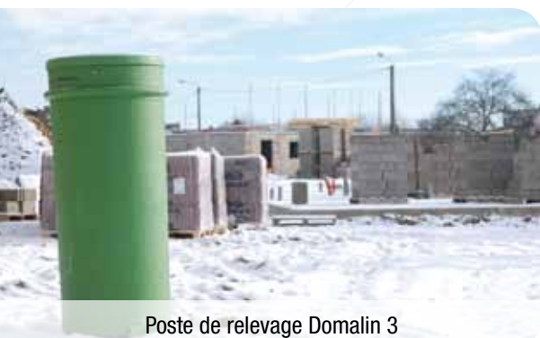
Fabrication d'un poste de relevage
